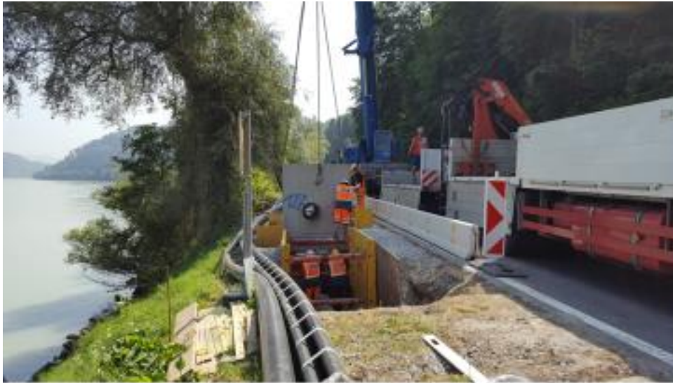
FT-Schacht mit Auftriebssicherung
